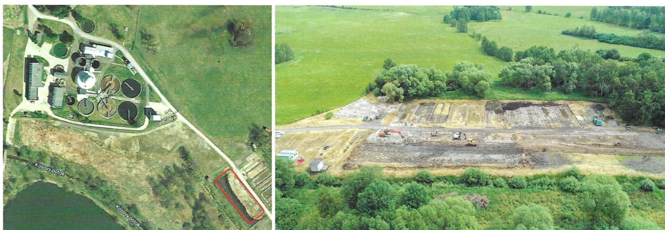
Obr. 1: Umístění a staveniště solární sušárny Mariánské Lázně
