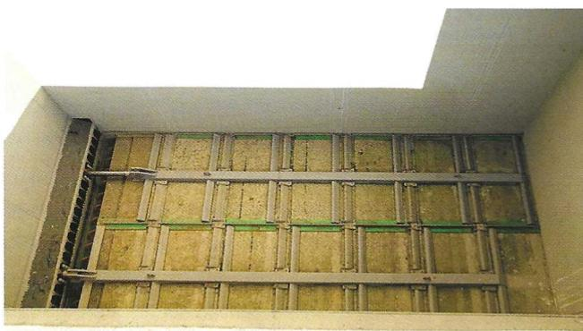
Obr. 2: Kalový bunkr pro odvodněný kal
