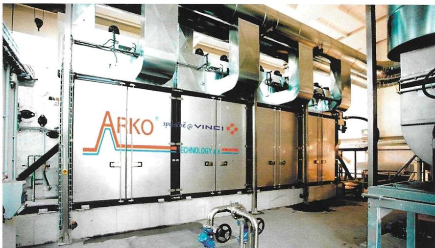
Obr. 6: Nízkoteplotní sušárna Pro-Dry M 2/4 LT (SÜLZLE KLEIN) na ČOV Přerov
