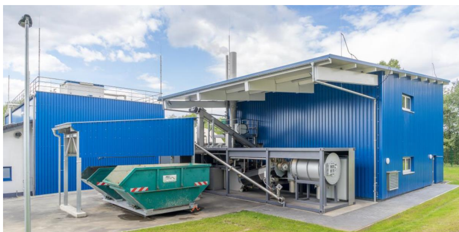
Obr. 5 – Objekt nízkoteplotní sušárny EloDry a pyrolýzní reaktor PYREG na ČOV Linz-Unkel (převzato z [11])
